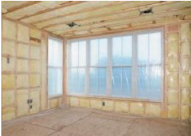
【外壁断熱工事】
