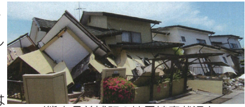
(熊本県益城町の地震被害状況)
