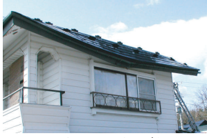
雪の重みで屋根が折れてしまいました。
