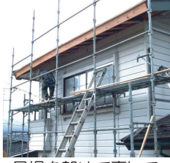
足場を架けて直しています。
