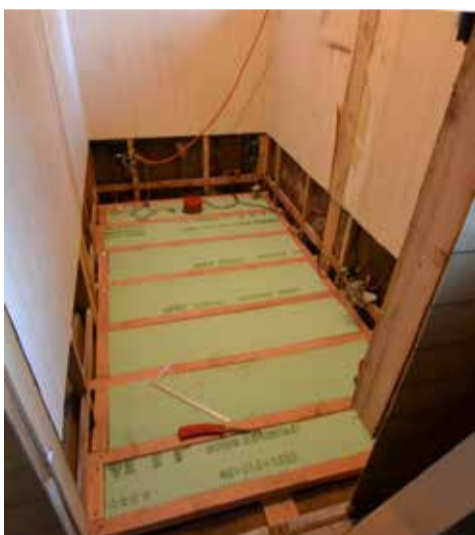
解体、床下げ、断熱材入れ
