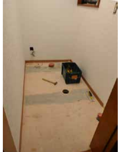
内装仕上げ中
