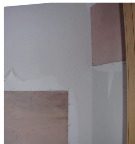
収納棚の下地造り
