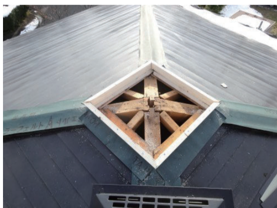
⑤防水処理のためルーフィングでカバーします。
