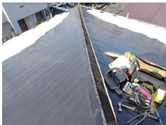
②方形屋根の隅棟を開いていきます。
