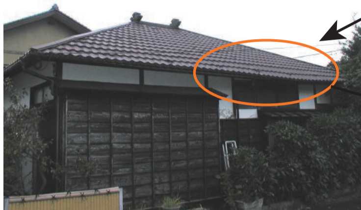
工事前＝折れた屋根の状況
