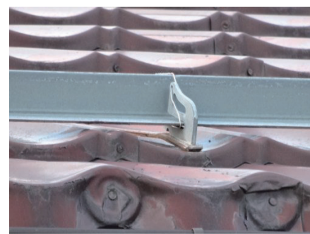
トタン瓦に専用金具を使用して、アングル雪止めを取り付けました。
