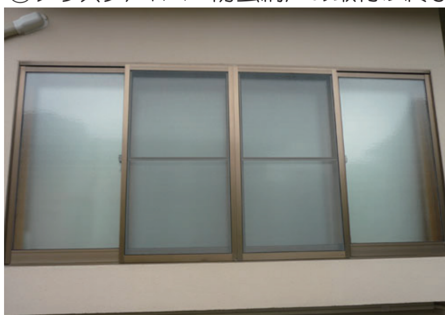
④グラスファイバー防虫網戸の取付け終了
