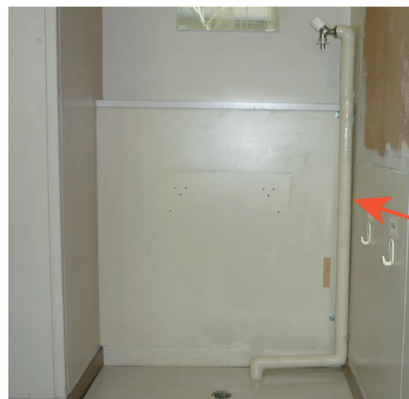
さらに給水管の保温をします。
