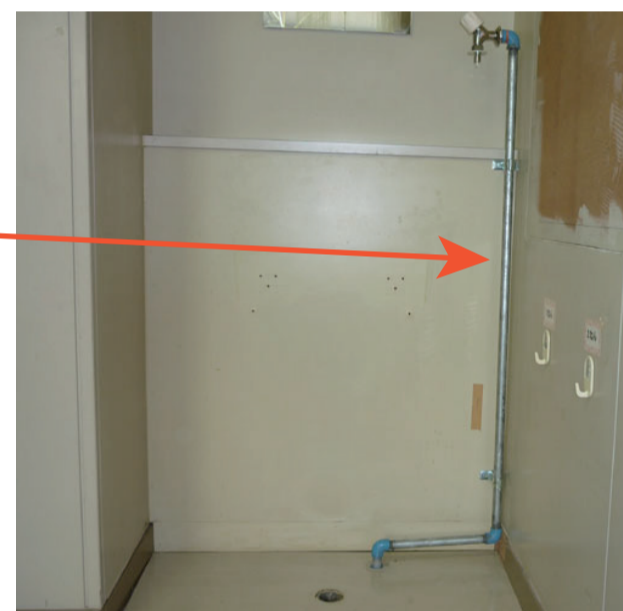
さらに給水管の保温をします。
