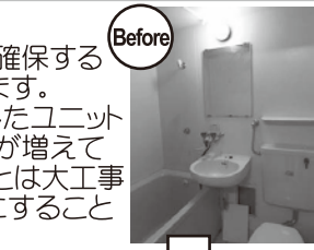
バス・トイレ同室の状態
