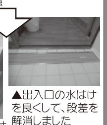
▲出入口の水はけを良くして、段差を解消しました
