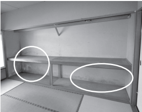
外壁に面した間口2間の押入内部が結露でカビ
