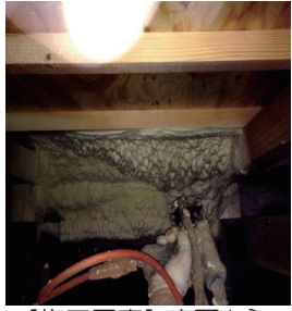
【施工写真】床下から、発泡ウレタン吹付け中
