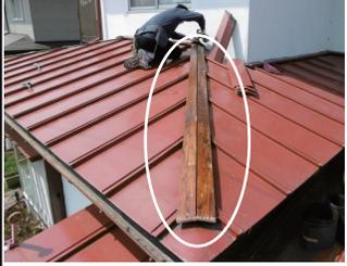
下地木材取替（ビス止め）+ 既存笠木再取付け+コーキング処理
