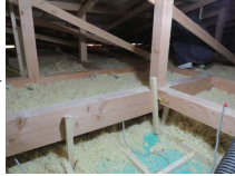
吹込みグラスウールを、厚み200mmで天井裏にスキマ無く吹き込んでいきます。
