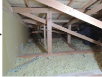
天井裏を断熱材で埋め尽くしました。
