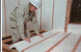
↑床下断熱工事中
