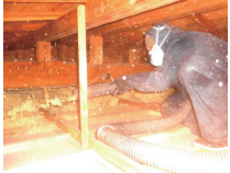
屋根裏にもぐりこみ断熱材を吹き込んでいます。
