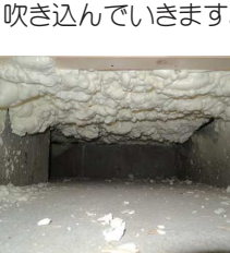
【施工後の床下】発泡ウレタンが分厚く床下を断熱します。
