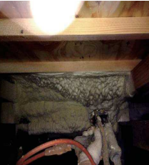
床下にもぐりこみ、発泡ウレタンを吹き付けています。
