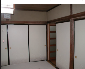
【工事前の和室の状況】
