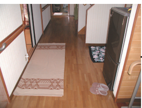
【廊下の寸法をきっちりと測り、部屋や階段の凸凹に合わせてカーペットを製作しました。】
