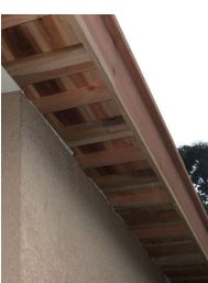
屋根下地の強化工事
