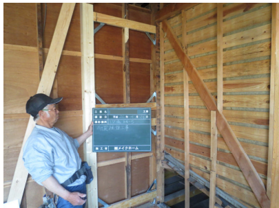
耐震工事中。筋交い、耐震金物を取り付け、この後、耐震ボードを張っていきます。
