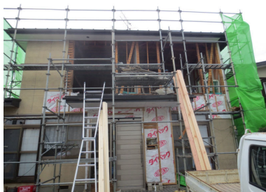
ただ今、全面リフォーム工事を進めております。
