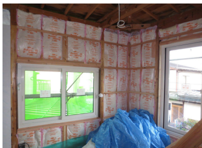
断熱樹脂サッシを取り付け、壁には断熱材を充填し、この後、防湿シートを張り、内部結露を防止します。
